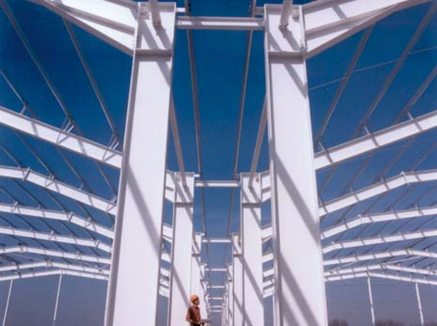
Figure 2.6 Portique à travée unique liaisonné
