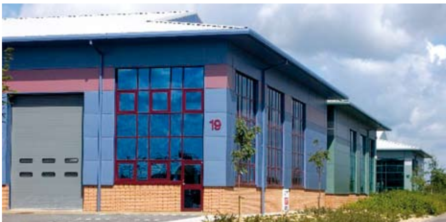
Figure 4.11 Grande fenêtre et panneaux mixtes avec "mur de protection en briques"
