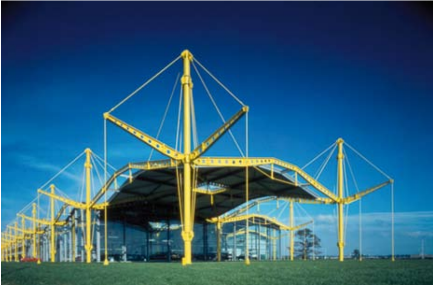
Figure 2.14 Structure suspendue utilisée à l'Usine Renault, Swindon, R.-U., construite dans les années 1980 Architect : Richard Rogers Partnership
